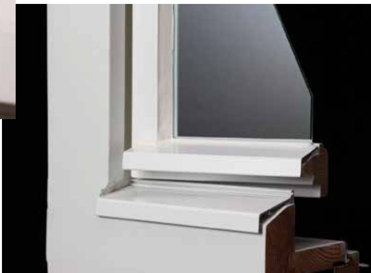
Sanierter Fensterflügel - wieder fit für viele Jahre.
